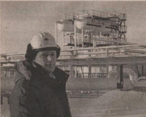
На Тепловском месторождении в нынешнем году сдана в промышленную эксплуатацию новая УПСВ. Установка, строительство которой начато в апреле 2006 года, была введена в производство согласно проекту и срокам сдачи 8 ноября текущего года. Проектная мощность установки предварительного сброса воды – 10 млн. тонн жидкости в год. Выходная продукция (нефть) – 0,8 млн. тонн в год с обводненностью до 1%, то есть нефть почти товарного качества.
