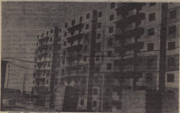
ПЫТЬ-ЯХ СТРОИТСЯ. (Лето 92 года)
