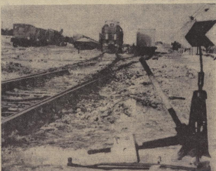
СТАНЦИЯ «ПЫТЬ-ЯХ» С ПАРАДНОГО ВХОДА И «ЧЕРНОГО». Фото С. ЩАДЕНКО.
